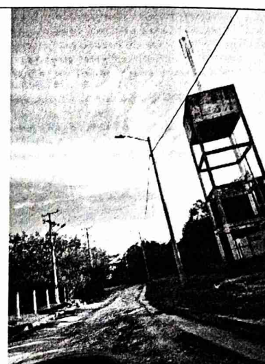
Imagen 9. Luminaria LED instalada en la vía Paradero-Margaritas, municipio de Flandes - Tolima.
